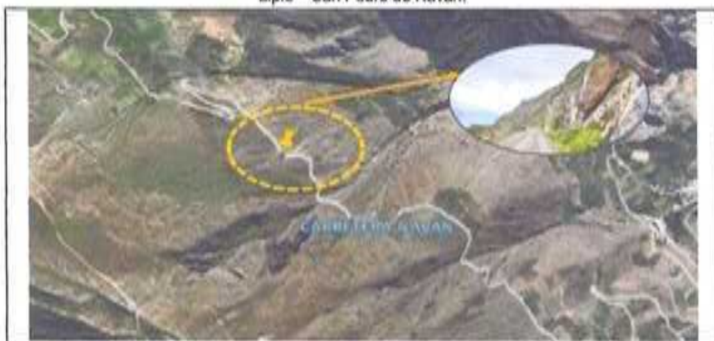
Figura N° 76. Ubicación del deslizamiento en el km 7+200 de la vía vecinal LM-579, Emp. PE-18 – Liple – San Pedro de Naván.
