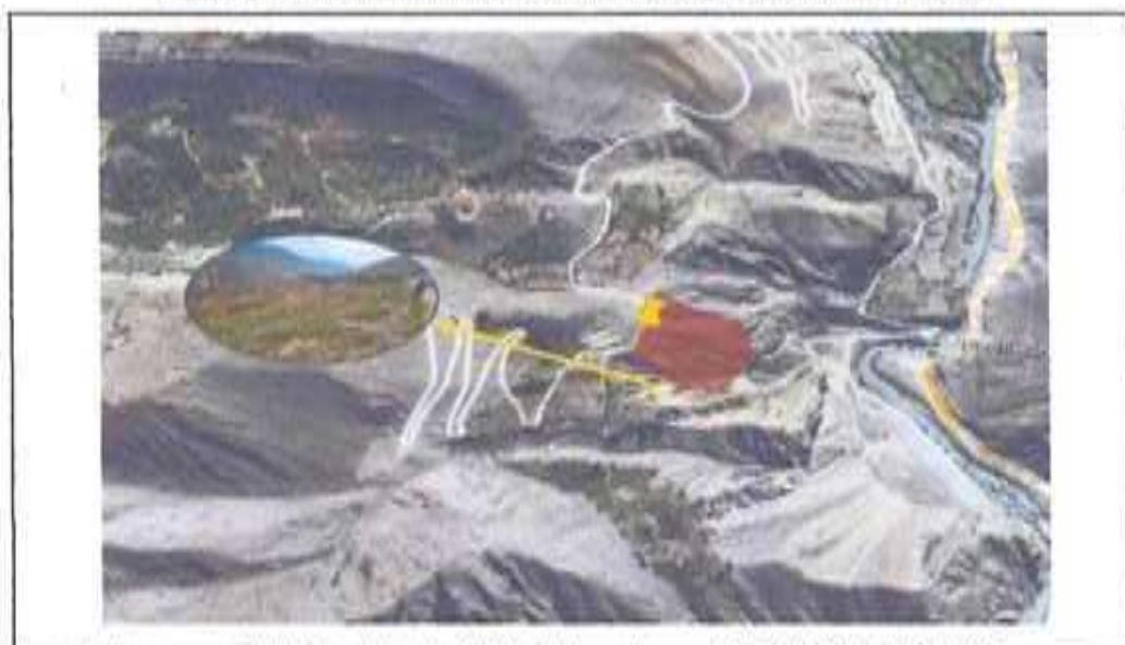
Figura N° 80. Delimitación del deslizamiento ruta Marahuay alto - Navan.
