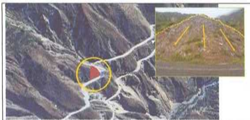
Figura N° 66. Delimitación de peligro de deslizamiento superficial de detritos y suelo en la Carretera Aguar -Caujul 7.7 km desde desvío Caujul
