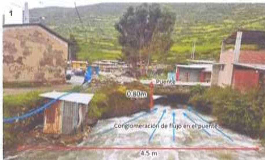
Figura N° 49. Peligro de inundación fluvial; (1) embotellamiento de flujo en el puente Ucruschaca, (2) bordes libres menores a un metro.
