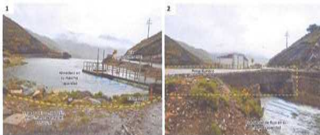
Figura N° 47. Peligro de inundación por desborde de represa; (1) condiciones de borde libre en relación a la cresta de la presa, (2) estado actual del material de la presa.
