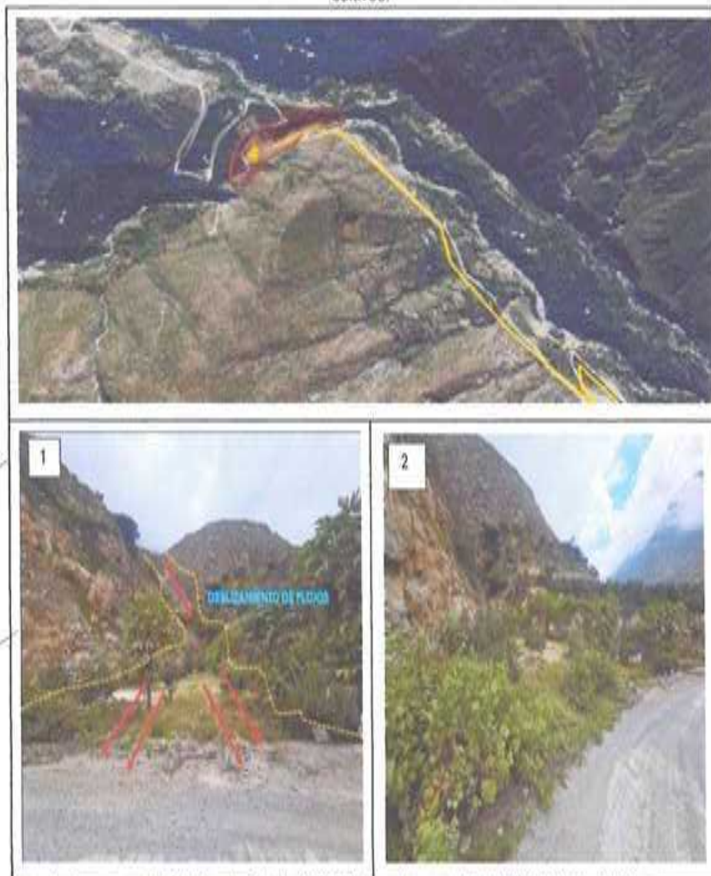
Figura N° 75. Delimitación de peligros de flujo de detritos en el Km6+100 de la vía vecinal LM-571. (1) se observa la quebrada con activación reciente (2) se observa afectación a vías vecinales y cultivos.
