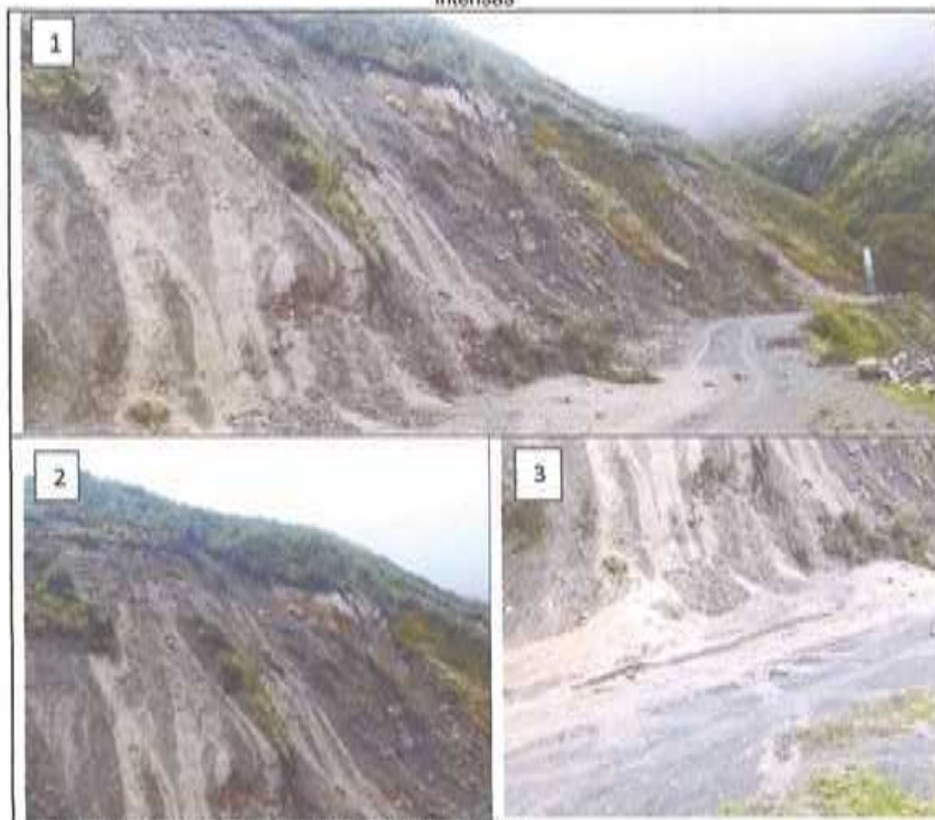
Figura N° 61. Panel fotográfico Ruta a Acaín - Desvío Beteta One Tingo 18 (Km 19+200), ZCO_18 (1) se observa afectación directa a la red vial vecinal (2) se observa material inconsolidado en la corona del deslizamiento (3) se observa arrastre de material detrítico a consecuencia de las lluvias intensas
