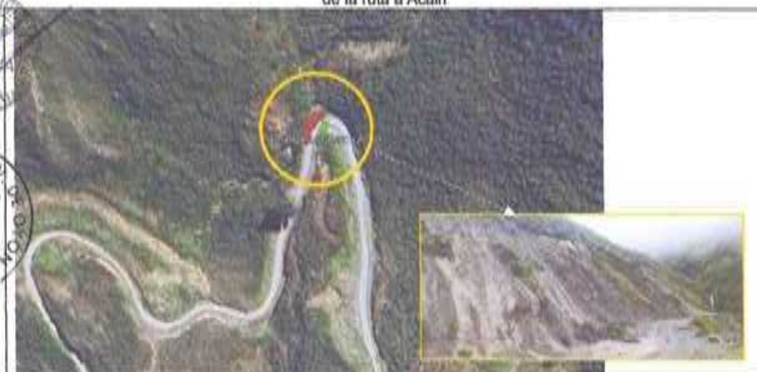
Figura N° 60. Delimitación de peligros de deslizamiento superficial de suelo y detritos en el km 19+200 de la ruta a Acain
