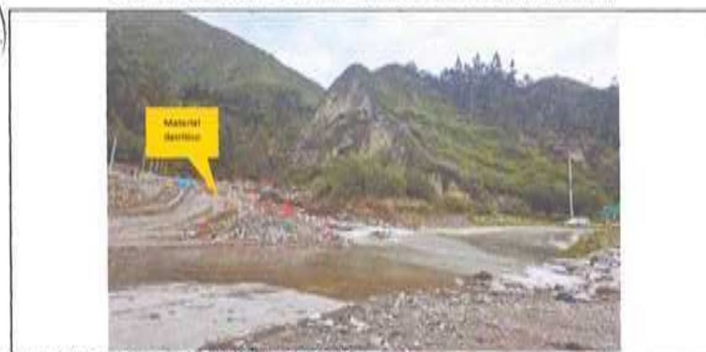
Figura N° 29. Badén de la vía PE-1N, expuesta y con escorrentía de flujo con caudalosos y evidencia de depósito de material detrítico de arrastre de la quebrada.
