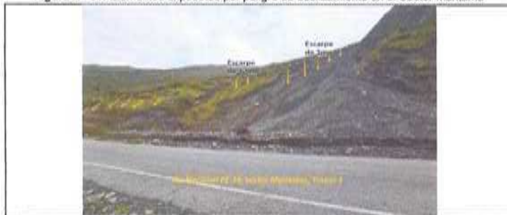
Figura N° 31. Elementos expuestos por peligro de deslizamiento en el Sector Maritama
