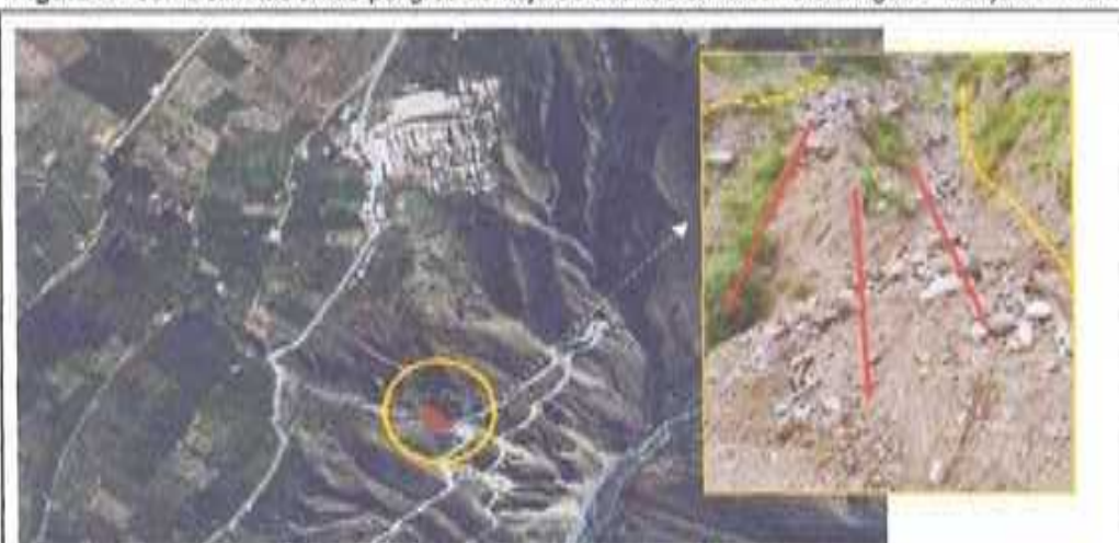
Figura N° 68. Delimitación de peligros de flujo de detritos en la carretera Aguar –Caujul km 7.65
