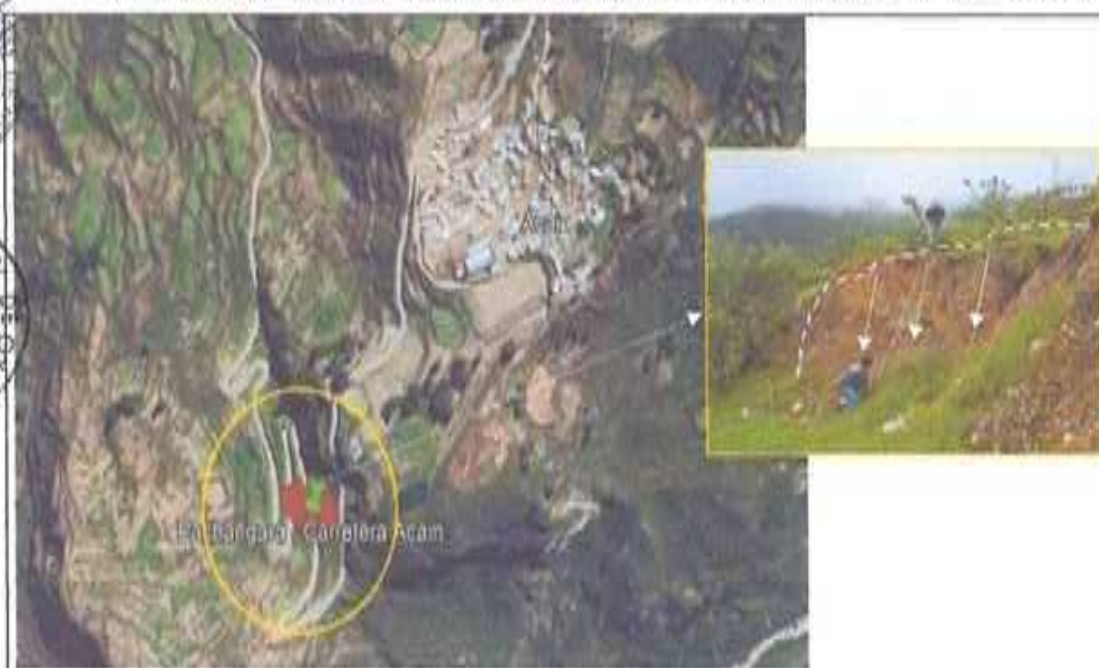
Figura N° 58. Delimitación de peligros de deslizamiento rotacional en el km 21 de la ruta a Acain
